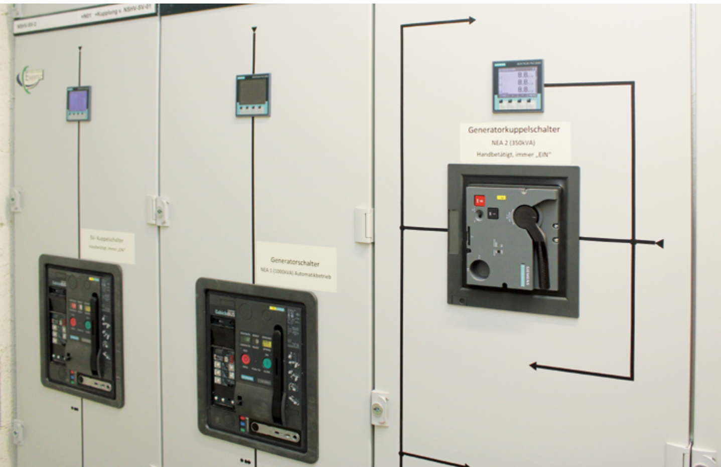
Schaltanlage einer modular aufgebauten Netzersatzanlage, Quelle: BBK
