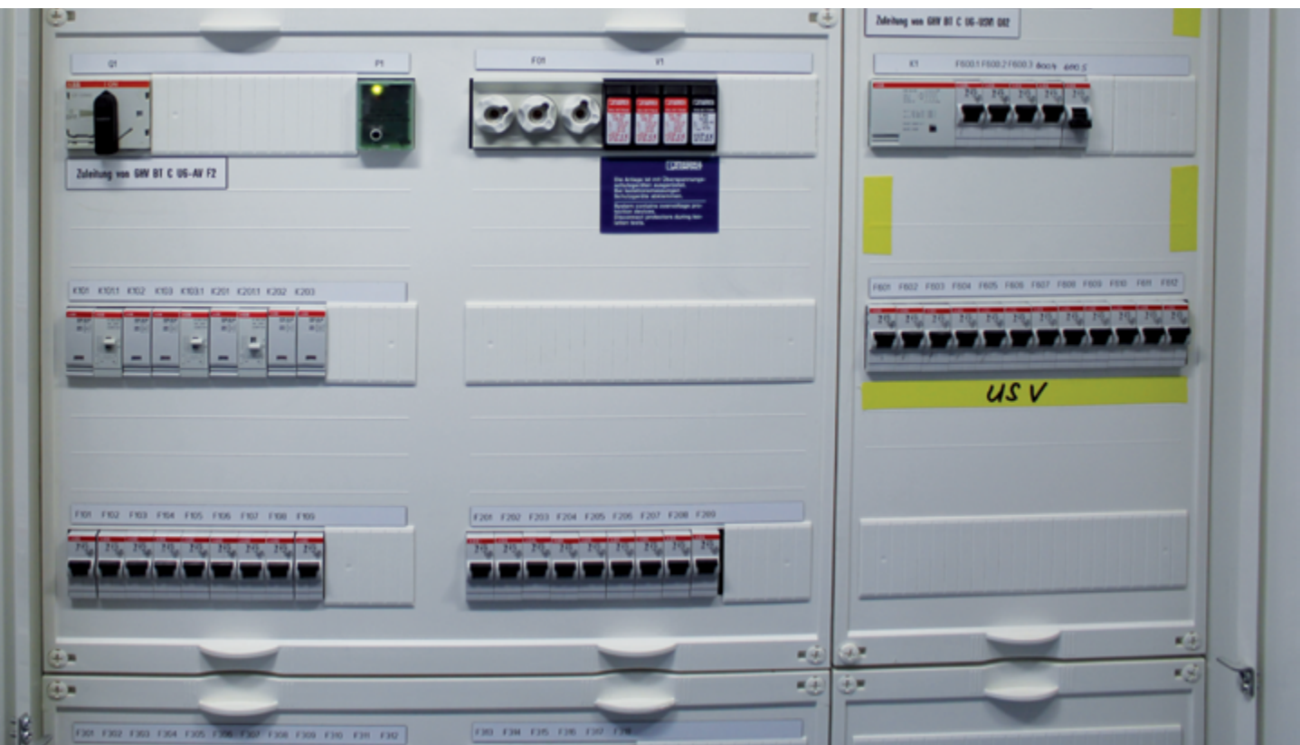
Etagenverteilung mit notstromversorgten Stromkreisen, Quelle: BBK
