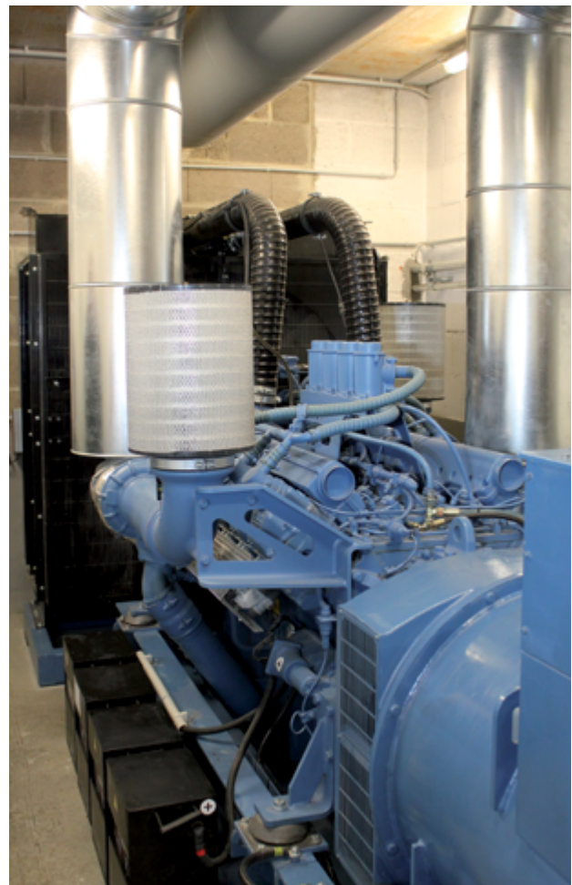
Netzersatzanlage Quelle: BBK
