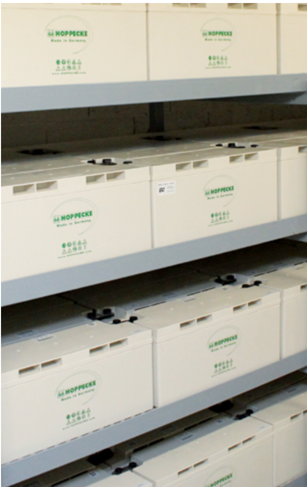
Batterieanlage für eine unterbrechungsfreie Stromversorgungsanlage Quelle: BBK
