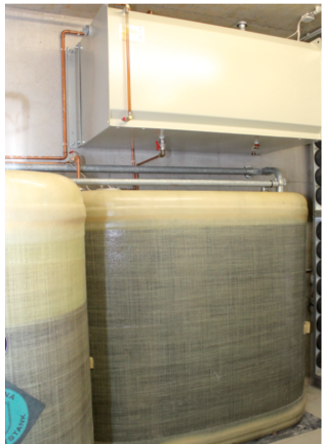
Haupt- und Tagestank einer Netzersatzanlage Quelle: BBK
